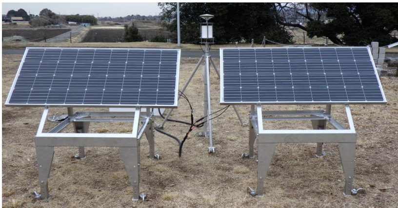
小型GNSS観測装置の外観
